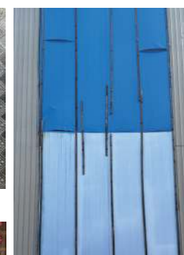
壁面の修復の様子
